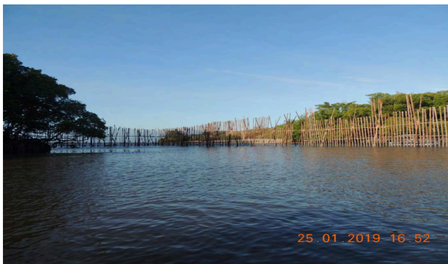
Figura 3. Avanço das obras no espaço de readaptação e reabilitação de peixe-boi marinho.
