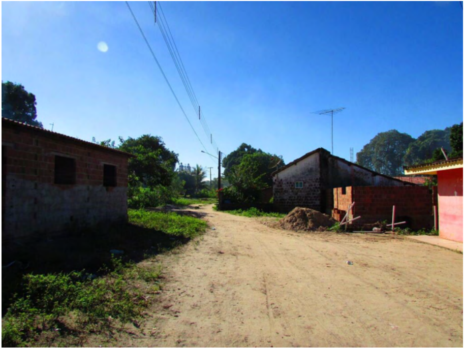
Figura 2. Ausência de Pavimentação e Sistema de Drenagem no Assentamento do Engenho Ubu
