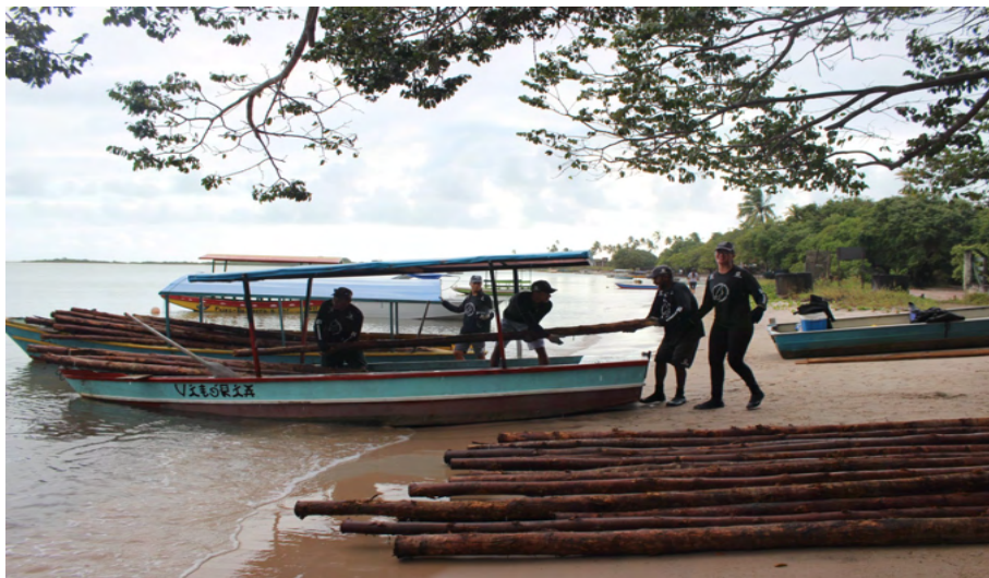
Figura 1. Embarque das estacas para a construção do espaço de readaptação e reabilitação do peixe-boi marinho.
