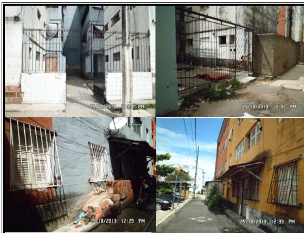
Fig. 4. Reformas nos prédios contra a violência. Legenda: Grades fechando os blocos do CHC. Foto de: Diana Gómez Bautista, aos 25 de outubro de 2013.
