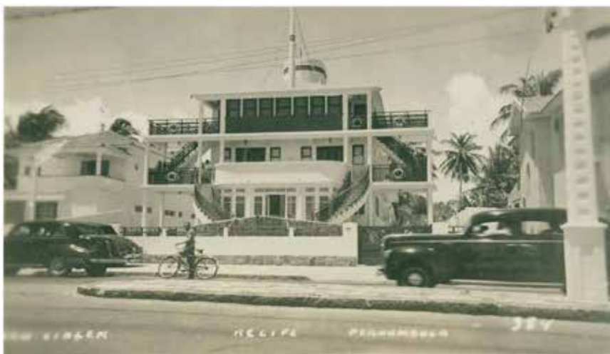
Figura 6: Antigo palacete localizado na Av. Beira-Mar, conhecido por Casa-navio, na década de 1950. Fotografia: Autor Desconhecido. Fonte: IBGE. Disponível em: http://biblioteca.ibge.gov.br/biblioteca-catalogo.html?id=440885&view=detalhes . Acesso em: 18 de nov. 2019.
