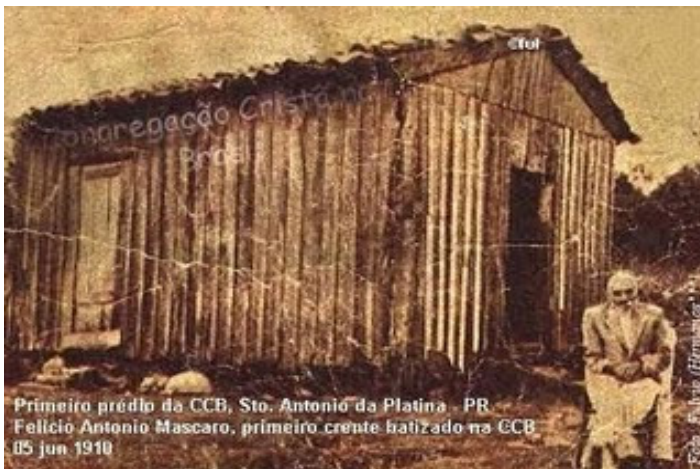
Figura 3: Primeiro prédio da CCB -PR e Felício Antônio Mascaro, primeiro crente batizado da CCB em 05 jun 1910. Fonte: Museu CCB.
