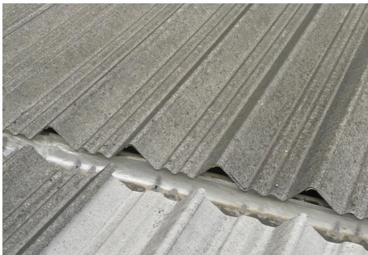
Figura 3.3.2 - Calha de concreto
