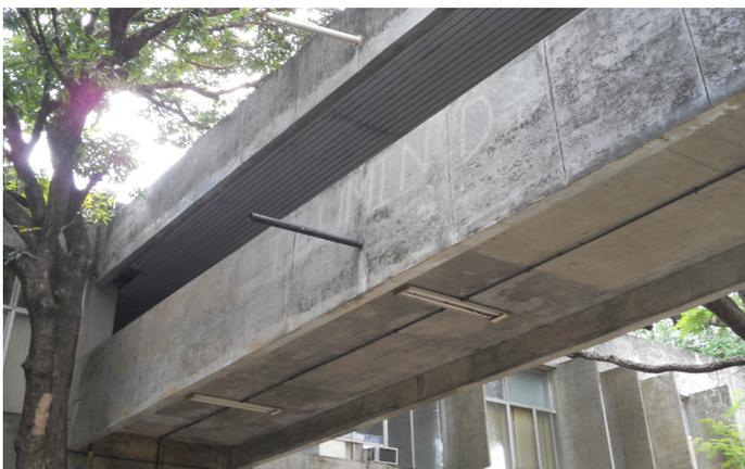
Figura 3.3.7 – Buzinote em tubo de amianto
