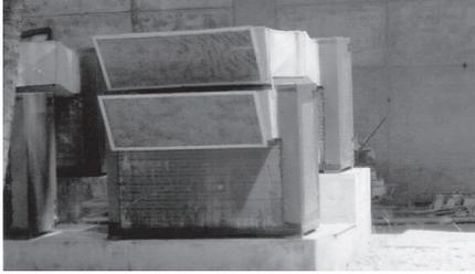
FOTOGRAFIA 3.7 Condensador do *Self Contained*
