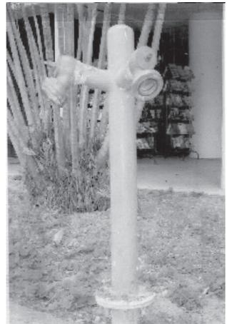
FOTOGRAFIA. 2.4. Hidrante de coluna
