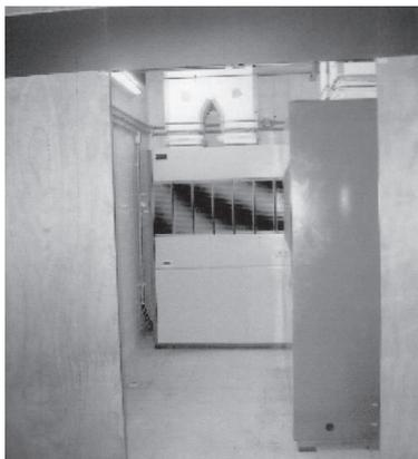
FOTOGRAFIA 3.6 *Self Contained* com condensação a ar
