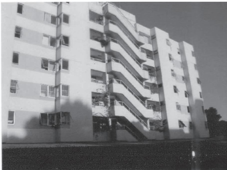
FOTOGRAFIA 2.26 Escada de emergência externa - fora da norma atual
