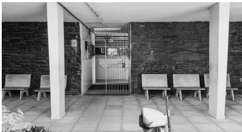
FIGURA 2. Pedra fundamental da UFPE, edificada no atual espaço físico do DN/ CCS, 1948
