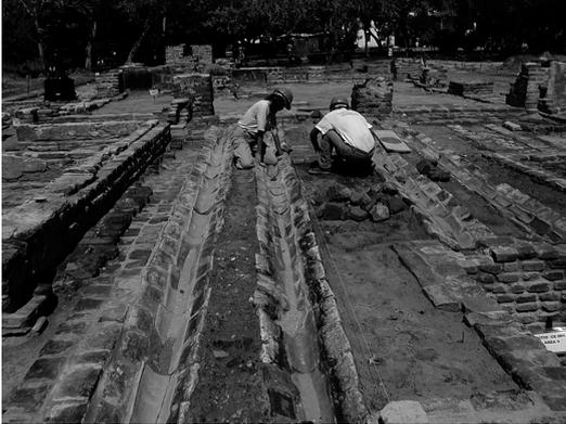
Figura 16: Canaletas re-vestidas com telha.
