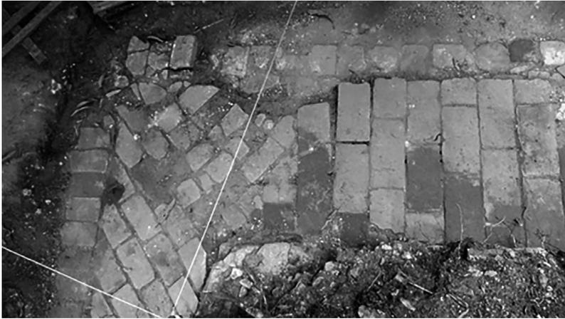
Figura 6: Quadrículas 4F e 5F, onde vemos dois arranjos (paginação) dos pisos da sarjeta da sacristia, no encontro entre fachada posterior e lateral. Fonte: Cláudia Oliveira. Set. 2015.
