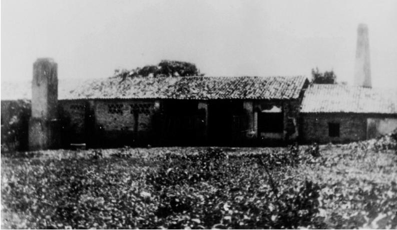
Figura 12: É importante observar nesta imagem a presença de duas chaminés, uma provavelmente associada à moagem e outra à fornalha de cozimento do caldo.
