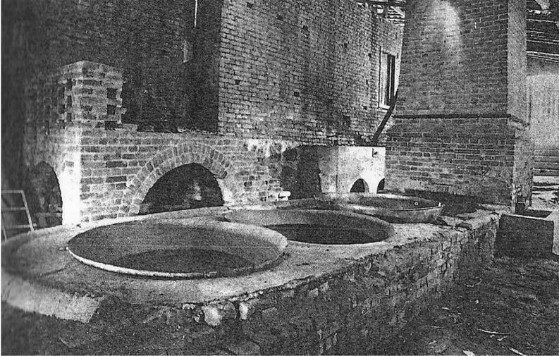
Figura 5: O trem jamaicano acoplado às tachas de cozer açúcar. Gama (1983:158).
