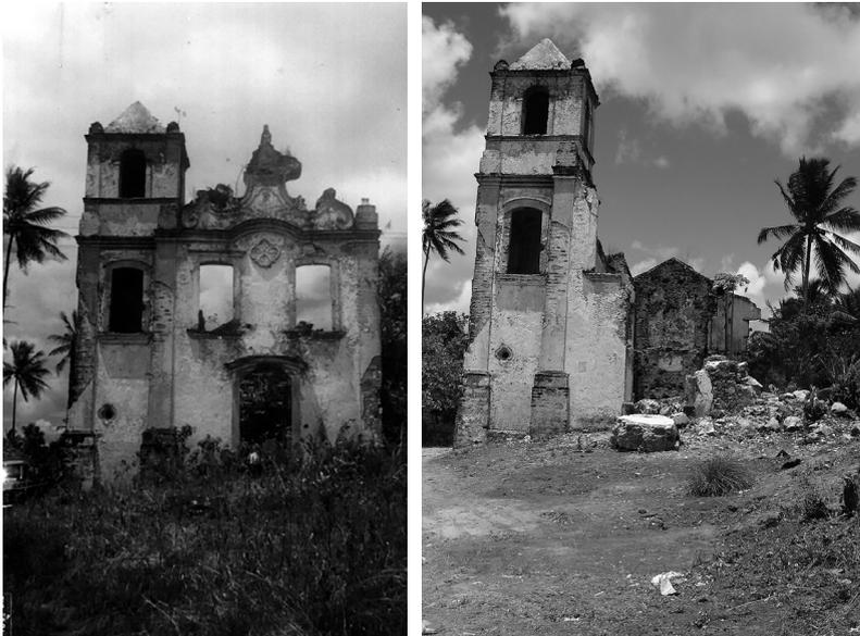
Figura 1. Fachada frontal da igreja em 1978 (esquerda) e em 2015 (direita): note-se a deterioração e desmoronamento da área do frontão e janelas frontais, bem como da porta principal da entrada, com perda de cantarias. Fonte: IPHAN, 1978; Oliveira, 2015.
