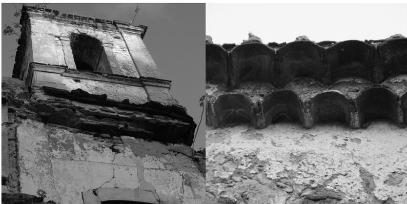
Figura 7. Detalhes das ações de vandalismo realizadas sobre a estrutura da ruína: incisões praticadas na argamassa de fixação de cantaria da porta central da nave central (acima a esquerda); incisões no fragmento de bloco de calcário usado no cunhal da torre do campanário; pichação na parede lateral interna da torre do campanário, inexistente até 2012; incisões no reboco da base interna do campanário. Fonte: Oliveira, 2015.
