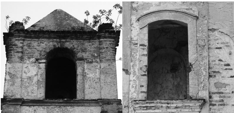
Figura 6. Detalhe do campanário, com aspectos de descascamento de argamassa e reboco, perda de ornatos da decoração e ação de fatores biológicos (esquerda). Detalhe de uma janela do campanário, na fachada frontal em degradação. Fonte: Oliveira, 2015.
