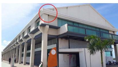
**FIGURA 15** Friso do Armazém 12, em destaque a falha na junção do friso das fachadas menores com as fachadas maiores. Fonte: Clara Patrício (2018).
