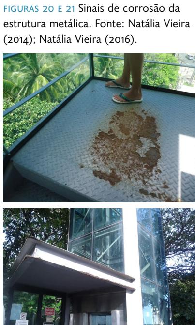
**FIGURAS 20 E 21** Sinais de corrosão da estrutura metálica. Fonte: Natália Vieira (2014); Natália Vieira (2016).
