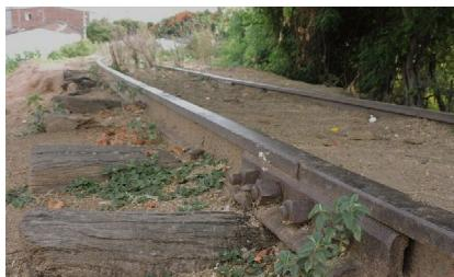
FIGURA 7 Detalhe da via permanente, com dormentes em madeira e trilhos. Fonte: Talys Medeiros (2021).
