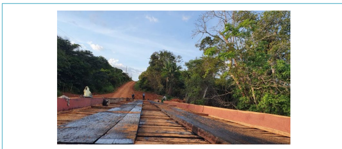
FIGURA 3. Ponte de madeira para interligar Novo Aripuanã e Apuí
