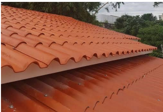
FIGURA 2. Telhado de cerâmica colonial
