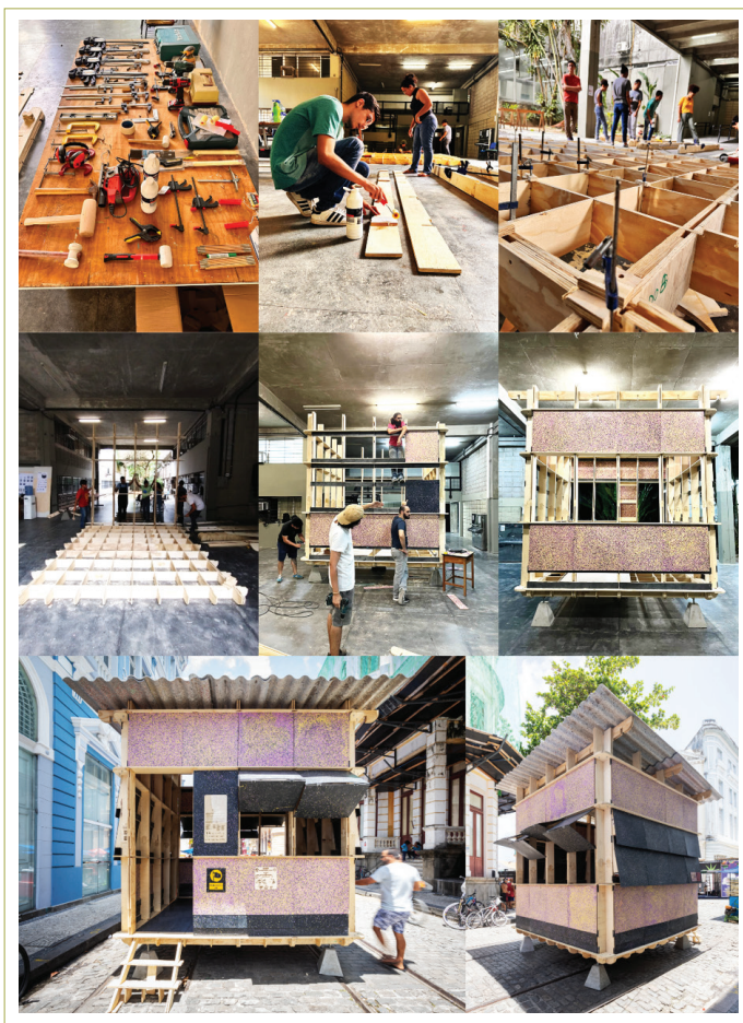
FIGURA 4. Registros da etapa de montagem do protótipo
