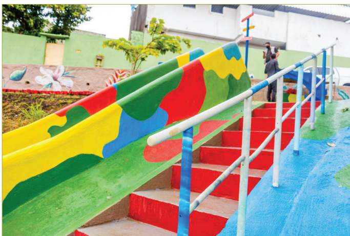
FIGURA 8. Produção de corrimão de escada com plástico reciclado instalado em intervenção do Programa Mais Vida nos Morros
