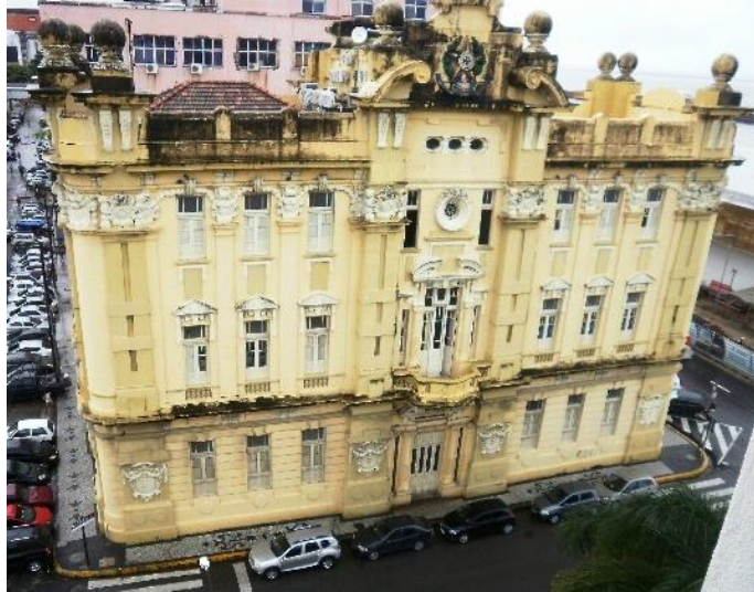
Figura 3 - Edifício de Fiscalização do Porto, situado a Rua Vital de Oliveira, 32 - Recife. Foto: a partir da Torre Malakoff, Marcia Cristina Alves, julho 2015.
