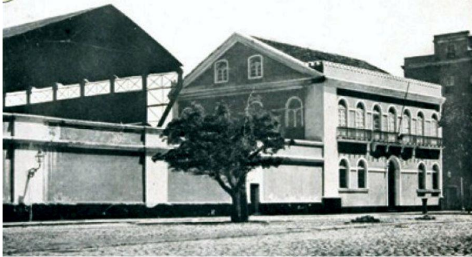
Figura 4 - Residência do Inspetor do Arsenal - fachada (demolida).s.d. Fotografia de aproximadamente 1910 - quando foi repartição dos correios. Disponível em: < http://www.ibamendes.com/search?q=recife >. Acesso em: 29 jan. 2019
