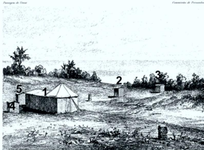
Figura 7 - Detalhe da gravura do observatório de Olinda (CRULS, 1882: 2:4.1). Legenda: 1- Observatório; 2- Objetiva da mira; 3- Mira; 4- Colimador norte e 5- bússola magnética.
