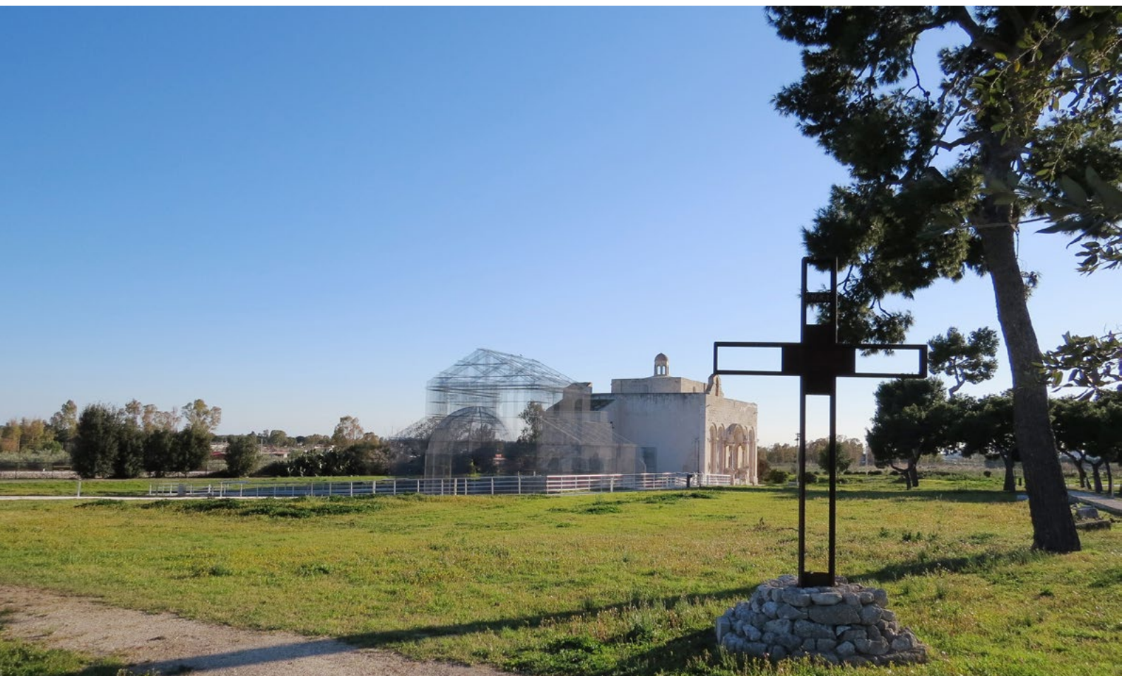
Figura 66: Acessando a área da basílica de Siponto a partir do Parque Arqueológico. Em primeiro plano, a estrutura metálica proposta por Edoardo Tresoldi, e, ao fundo, a Igreja românica de Santa Maria Maggiore. Fonte: Natália Vieira-de-Araújo, fev. 2020.
