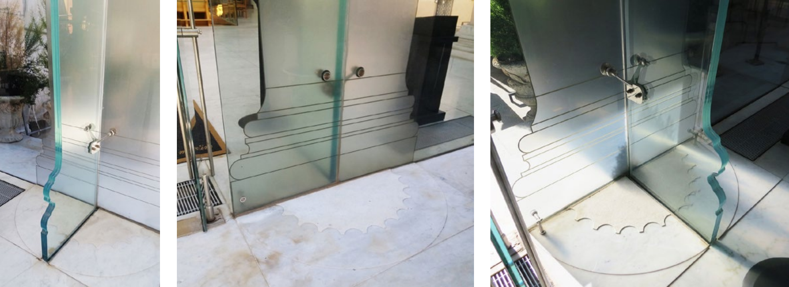
Figuras 157, 158 e 159: Diferentes soluções adotadas para resgatar as colunas do templo, incluindo a adoção de recomposições em vidro para locais onde não existiam vestígios materiais das antigas colunas. Poderíamos dizer que o projeto busca a “unidade potencial” do templo? Fonte: Natália Vieira-de-Araújo, dez. 2019.
