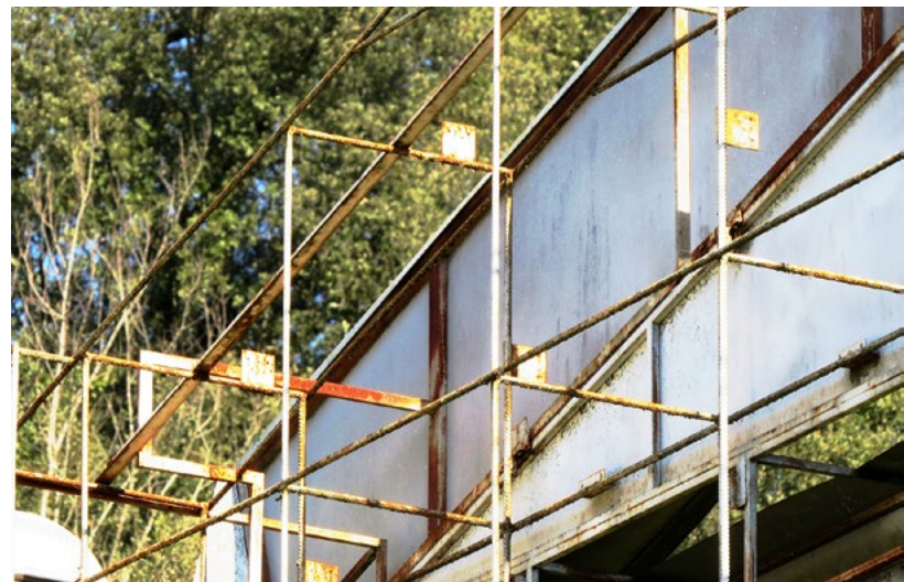
Figuras 61, 62, 63 e 64: Na primeira figura observamos o detalhe da conexão da grelha metálica com os vestígios arqueológicos. Repare que a grelha não os toca. Na segunda, detalhe de um dos cabos de aço de sustentação da grelha metálica e sua fixação no terreno. Nas figuras 63 e 64, infelizmente, salta aos olhos o mau estado de conservação da estrutura metálica. Fonte: Natália Vieira-de-Araújo, jan. 2020.
