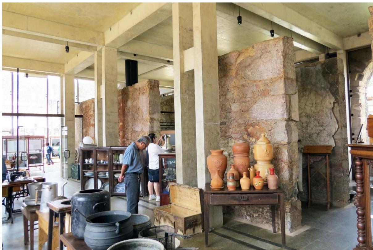
Figuras 22 e 23: Santuário do Caraça, em Minas Gerais. Interior da intervenção nas ruínas da ala incendiada, com a clara distinção entre a estrutura de concreto armado inserida e os remanescentes da ala do colégio. Fonte: Natália Vieira-de-Araújo, set. 2016.
