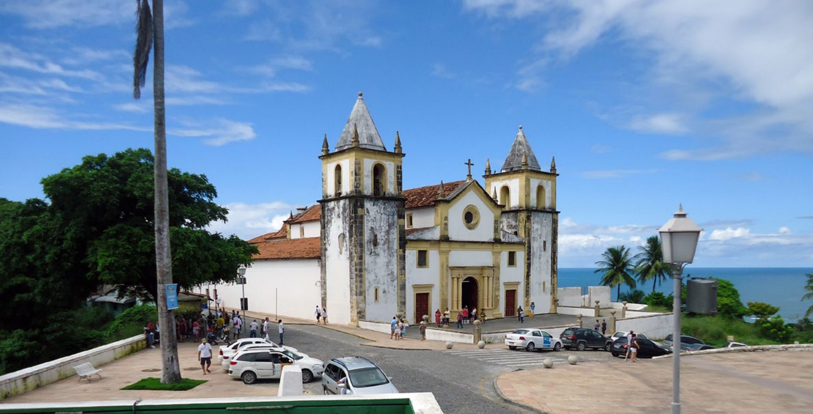
Figura 9: Igreja da Sé em Olinda após o projeto de restauração realizado na década de 1970. Fonte: Natália Vieira-de-Araújo, jun. 2011.
