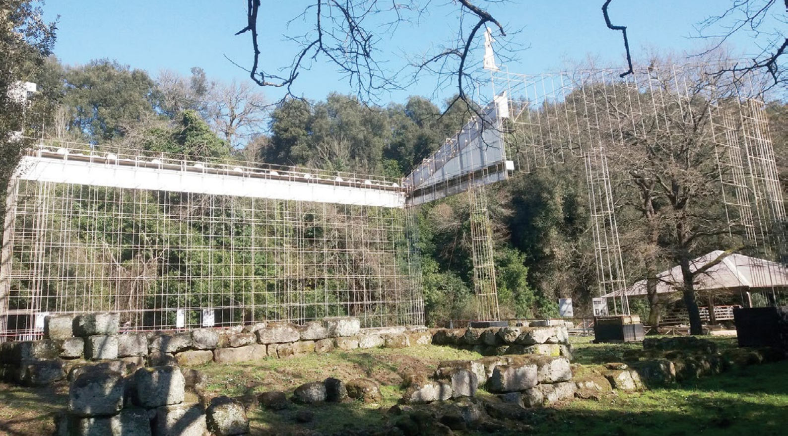
Figura 51: Em primeiro plano, os vestígios da lateral do Templo de Apolo em Veio, em Roma, onde a proposta de Franco Ceschi (1992) deixa apenas os vestígios, sem a inserção da estrutura metálica. Fonte: Natália Vieira-de-Araújo, jan. 2020.
