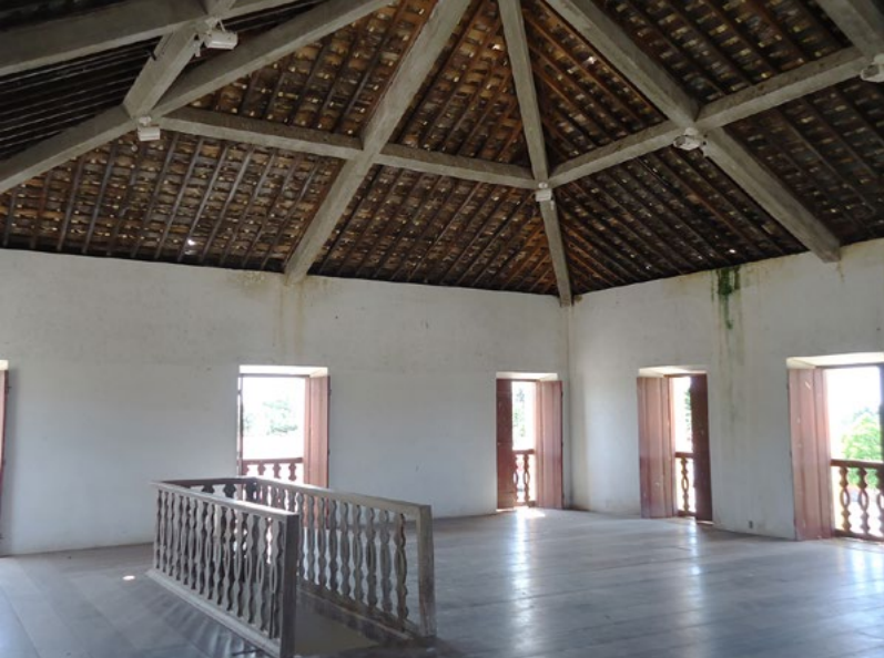
Figuras 15 e 16: Vista interna atual da Casa de Câmara e Cadeia em Vila Flor (RN), com destaque para a estrutura em concreto armado realizada para a recomposição da cobertura. Fonte: Natália Vieira-de-Araújo, jun. 2013.
