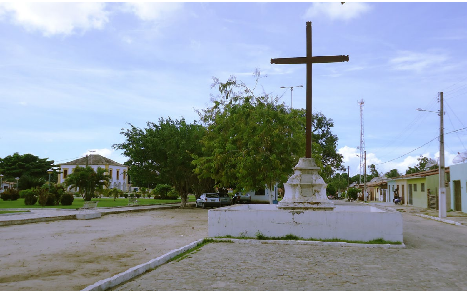
Figura 12: Vista atual do conjunto urbano a partir do cruzeiro da Igreja Nossa Senhora do Desterro, em Vila Flor (RN), com a Casa de Câmara e Cadeia ao fundo do lado esquerdo e casario do lado direito. Fonte: Natália Vieira-de-Araújo, jun. 2013.
