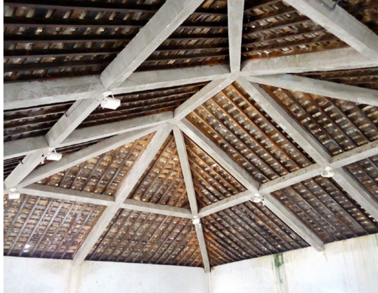
Figuras 15 e 16: Vista interna atual da Casa de Câmara e Cadeia em Vila Flor (RN), com destaque para a estrutura em concreto armado realizada para a recomposição da cobertura. Fonte: Natália Vieira-de-Araújo, jun. 2013.
