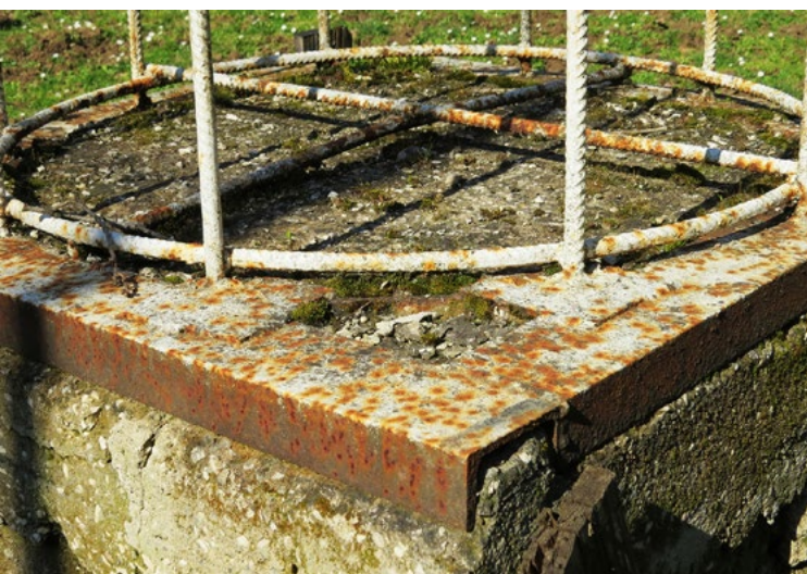
Figuras 61, 62, 63 e 64: Na primeira figura observamos o detalhe da conexão da grelha metálica com os vestígios arqueológicos. Repare que a grelha não os toca. Na segunda, detalhe de um dos cabos de aço de sustentação da grelha metálica e sua fixação no terreno. Nas figuras 63 e 64, infelizmente, salta aos olhos o mau estado de conservação da estrutura metálica. Fonte: Natália Vieira-de-Araújo, jan. 2020.
