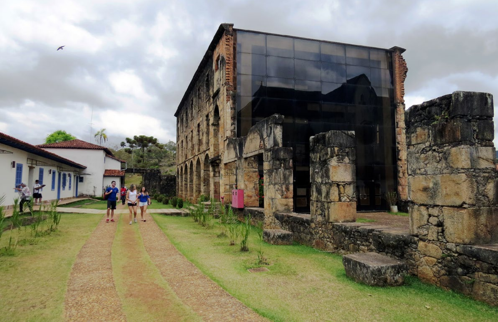
Figura 20: Santuário do Caraça, em Minas Gerais. Vista externa da ala que sofreu o incêndio, após intervenção. Fonte: Natália Vieira-de-Araújo, set. 2016.
