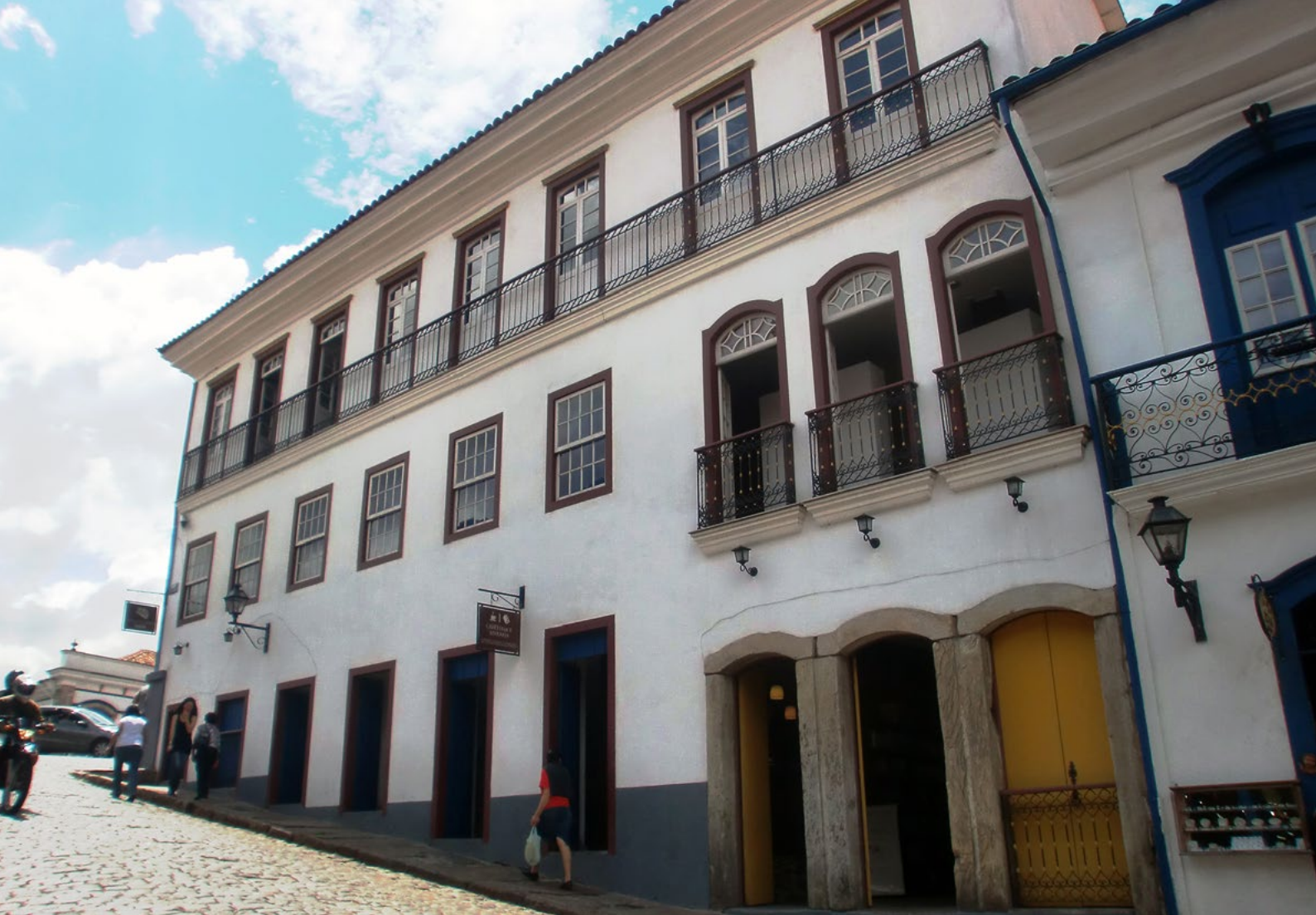
Figura 30: Casarão reconstruído na Praça Tiradentes, em Ouro Preto. Note-se na imagem a única área remanescente da edificação que sofreu o incêndio: as três portadas em pedra no canto direito inferior da imagem. O remanescente e o reconstruído estão completamente fundidos sem que se possa distinguir satisfatoriamente as partes do edifício e a passagem do tempo e dos eventos sobre este. Fonte: Paula Maciel Silva, out. 2011.
