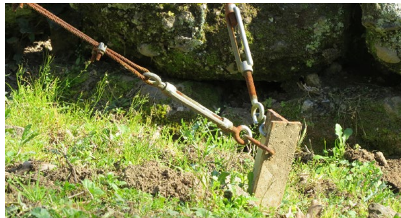
Figuras 61, 62, 63 e 64: Na primeira figura observamos o detalhe da conexão da grelha metálica com os vestígios arqueológicos. Repare que a grelha não os toca. Na segunda, detalhe de um dos cabos de aço de sustentação da grelha metálica e sua fixação no terreno. Nas figuras 63 e 64, infelizmente, salta aos olhos o mau estado de conservação da estrutura metálica. Fonte: Natália Vieira-de-Araújo, jan. 2020.
